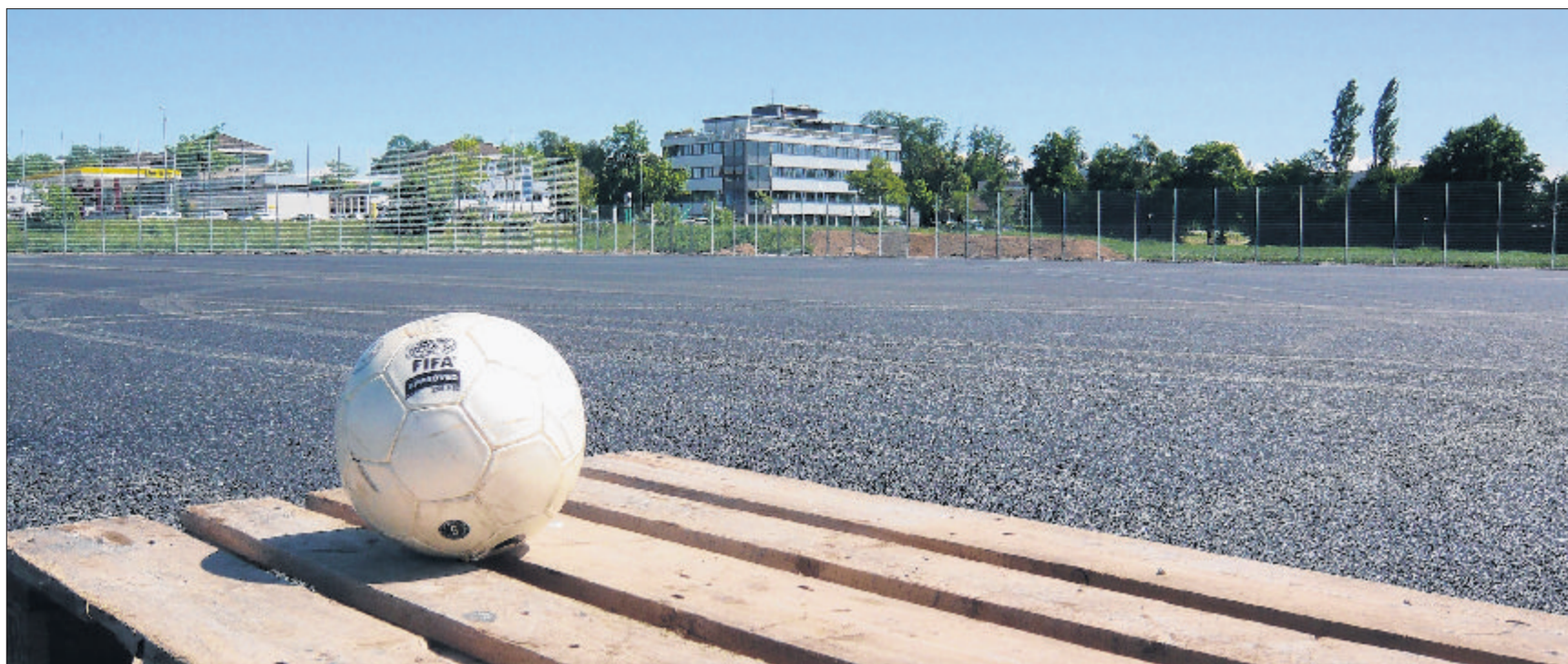
Gleicht momentan noch mehr einem Autoparkplatz: das neue Kunstrasen-Fussballfeld auf der Ustermer Sportanlage Buchholz. (thi)
